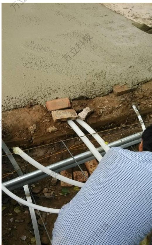
图 5-3 放置穿线管、钢筋笼、预埋件
