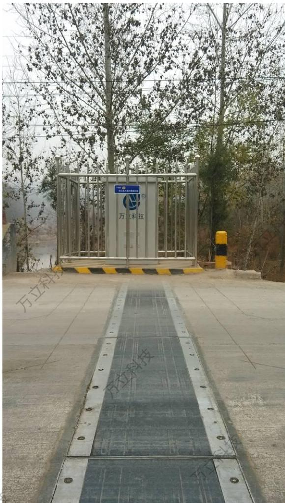
图 3-2 弯板式动态称重系统图
