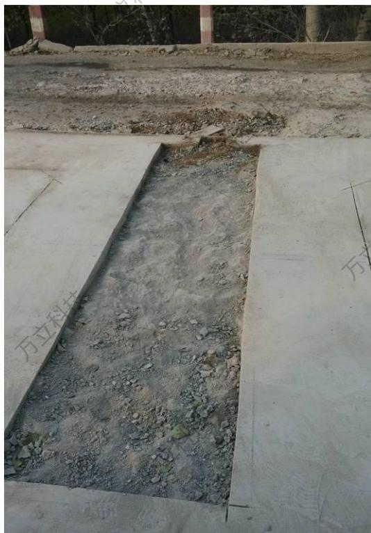
图 5-5 弯板称重秤台切缝
