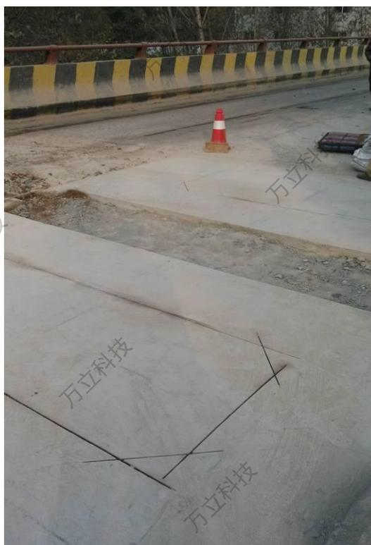
图 5-6 地感线圈切缝
