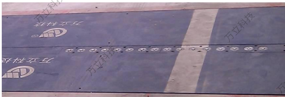
图 4-2 轮轴检测单元测轮器现场图
